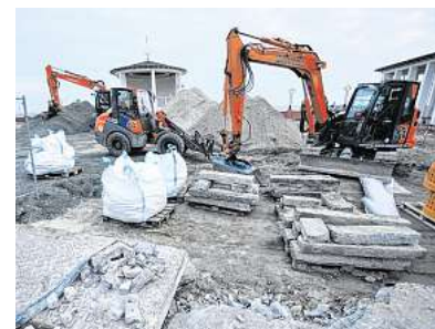
Das alte Pflaster des Kurplatzes wird komplett aufgenommen. FOTO: KV BINZ
